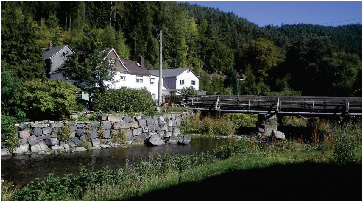
Abbildung 11.34: Blick von oberstrom auf die Brücke R.-Breitscheid-Straße bei km 25+526
