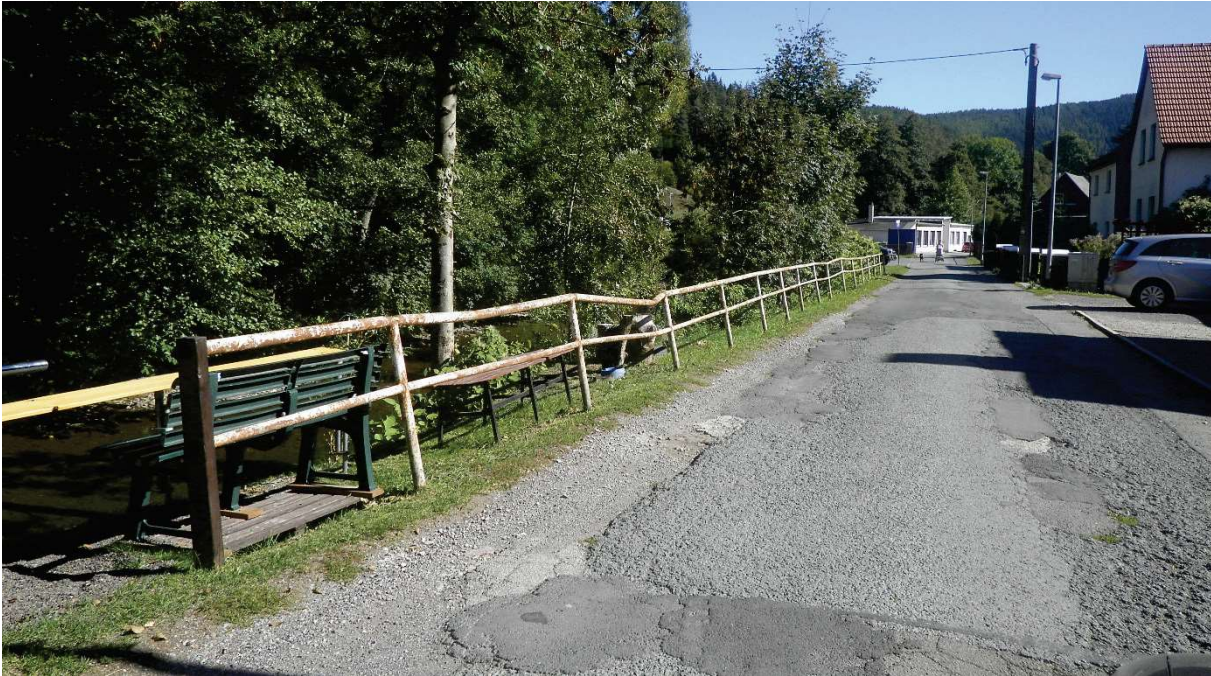
Abbildung 11.35: Erscheinungsbild der Fröbelstraße in Glasbach bei km 26+100
