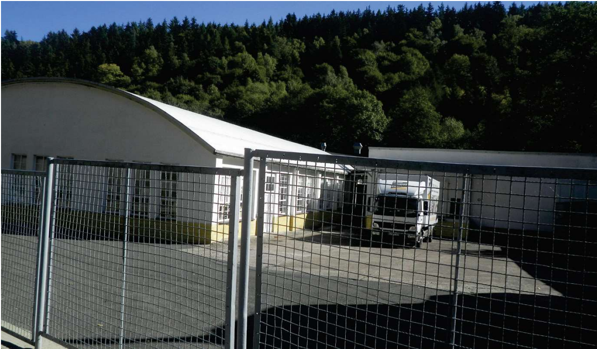
Abbildung 11.40: Ab HQ 10 betroffene Betriebsgebäude in Glasbach bei km 27+300
