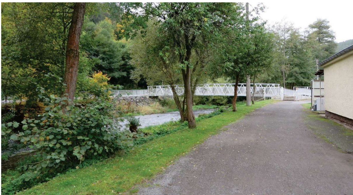
Abbildung 11.30: Blick auf die Fußwegbrücke am Sportplatz von unterstrom am linken Ufer
