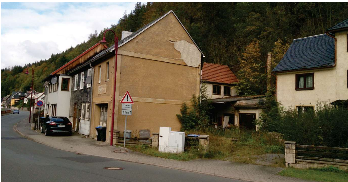
Abbildung 11.46: Gebäude nördlich der Straße L1112 auf dem linken Ufer bei km 27+900
