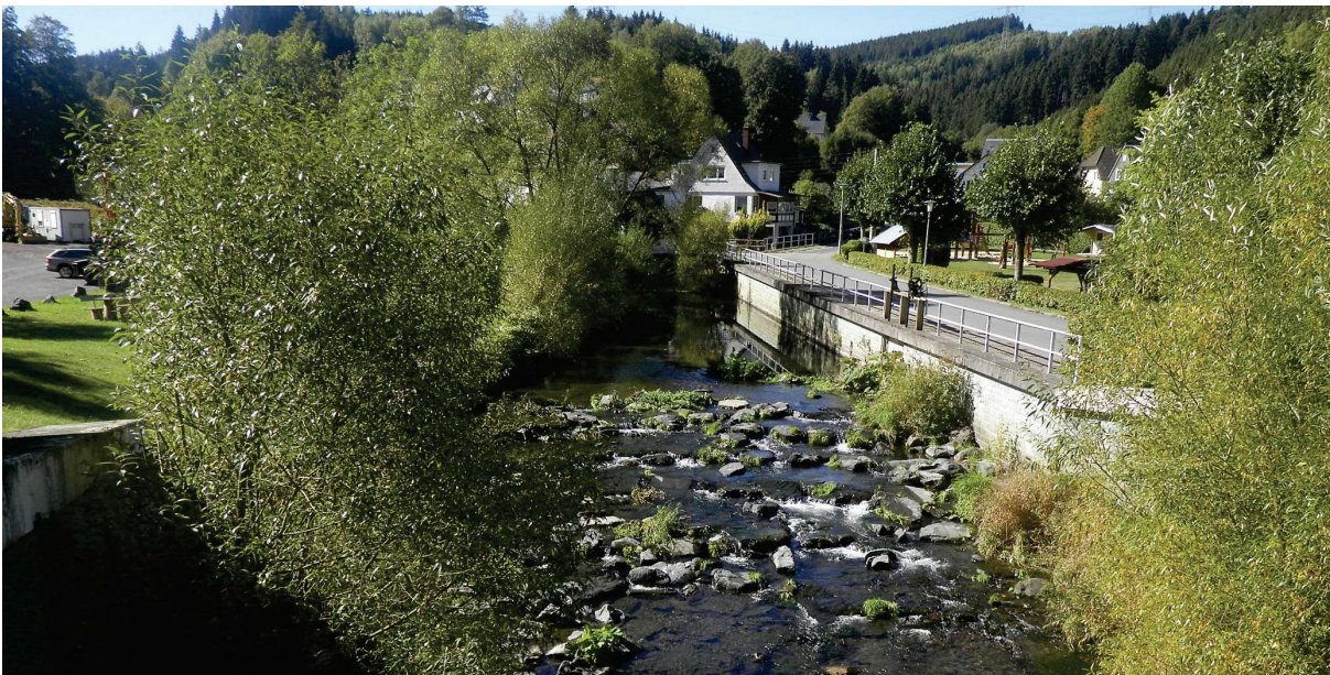
Abbildung 11.58: Blick von der Brücke Mellenbacher Straße bei km 33+348 gegen die Fließrichtung, Ortsstraße am linken Ufer (rechts im Bild)
