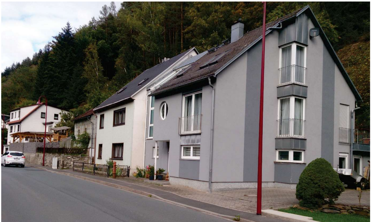
Abbildung 11.47: Gebäude nördlich der Straße L1112 auf dem linken Ufer bei km 28+000
