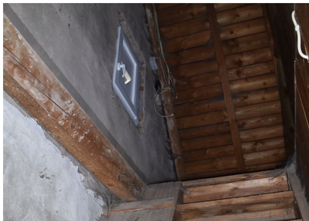
1c. Innenansicht Einflugloch im Dachboden
