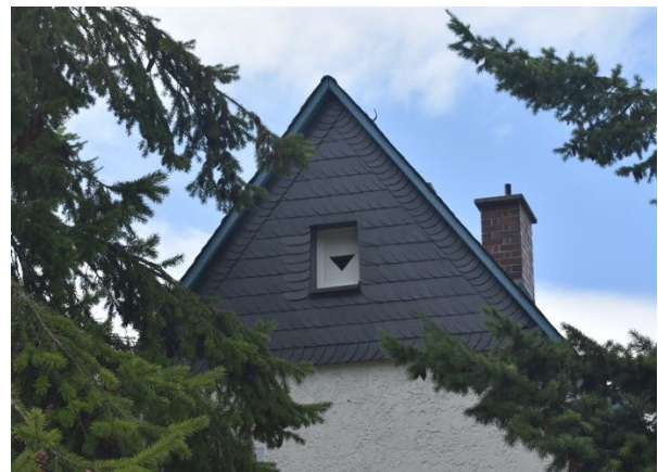
1b. Einflugloch für Fledermäuse im Dachstuhl
