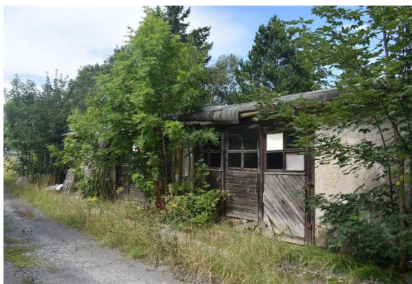
5e. Außenansicht, Blickrichtung Nordost
