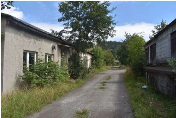
6c. Links: Gebäude 6, Blickrichtung Osten
