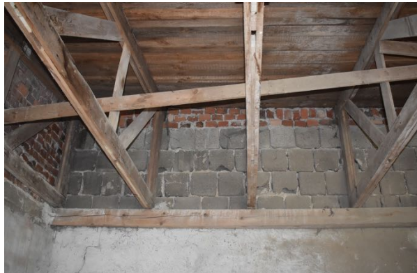
8d. Innenansicht mit offenen Hohlsteinen
