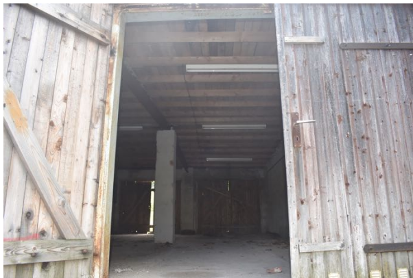
7c. Offenstehender Innenbereich
