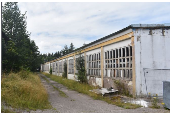
4e. Außenansicht Rückseite, Blickrichtung Nordost
