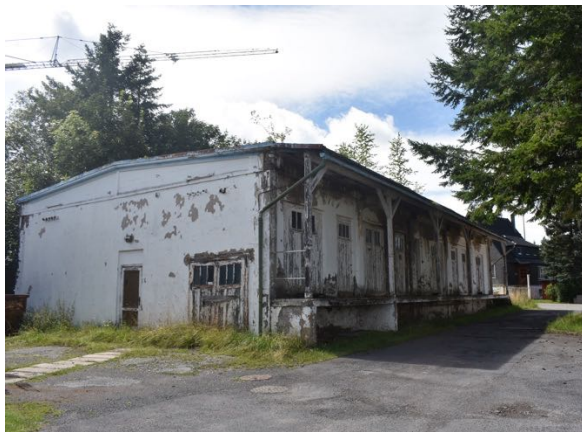
2a. Außenansicht, Blickrichtung Nordwest
