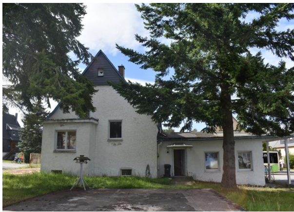
1a. Außenansicht Ostseite
