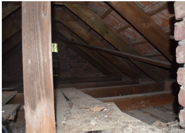
3d Blick in den Dachstuhl
