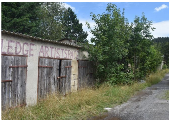
5c. Außenansicht, Blickrichtung Nordost mit Aufwuchs vor dem Gebäude
