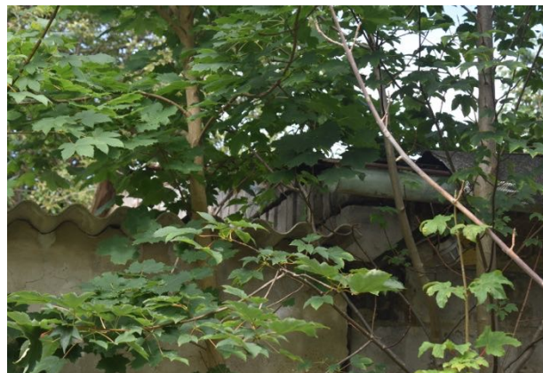
5d. Offene Fugen im Mauerwerk
