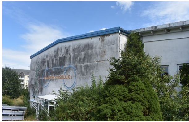
4b. Außenansicht, Blickrichtung Osten
