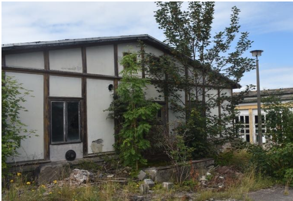
6a. Außenansicht, Blickrichtung Nordwest
