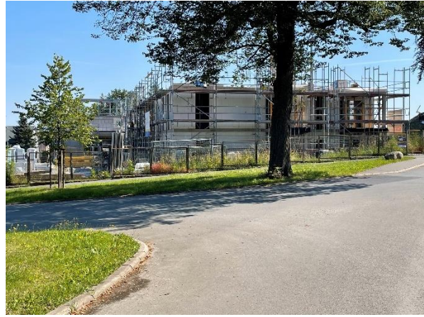
im Bau befindliches Wohngebäude mit barrierefreien Wohnungen
