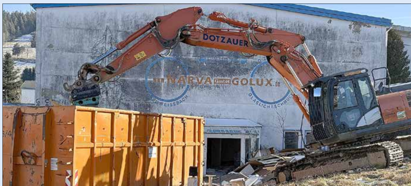
Beginn der Abrissarbeiten am 20.01.2025
